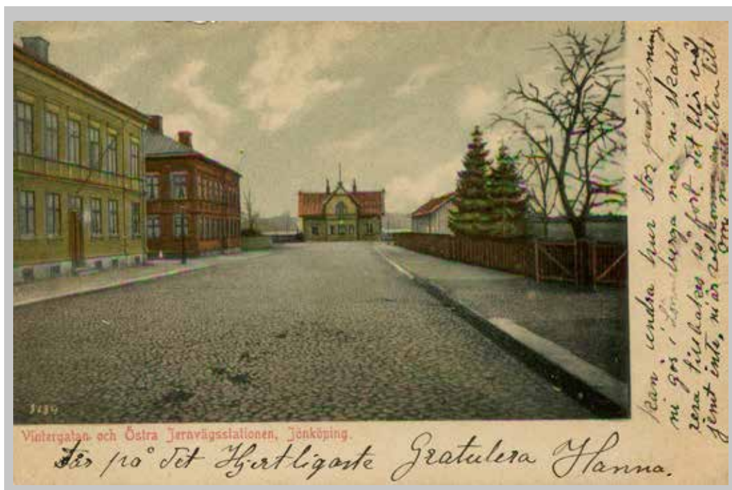
Vintergatan och Östra Jernvägsstationen. Jönköping. Gripenbergsbanan utgick från Jönkö- pings Östra station och avståndet till Vireda var 44,1 km. Denna station låg nära stationen vid Vaggerydsbanan. Stämplat Lönneberga 19/7 1906.
