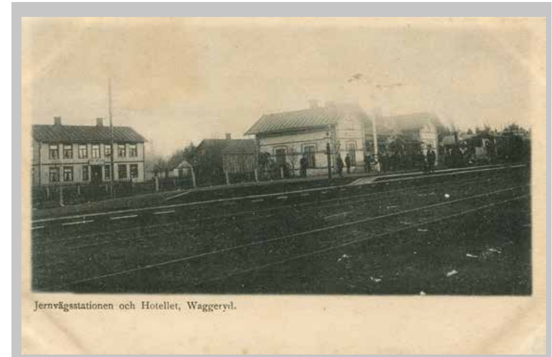
Järnvägsstationen och Hotellet, Waggeryd. Stämplat Waggeryd 30/1 1904 skickat till Götafors ett par kilometer bort. Cirka 15 personer syns och ett ånglok står inne på stationen. Trycktekniken var inte den bästa på detta kort. I Sverige var man inte lika långt framme som i Tyskland. Detta kort är troligen tryckt i Sverige senast 1903 eller möjligen något år tidigare.
