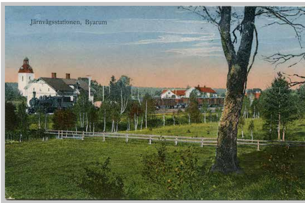
Järnvägsstationen, Byarum. Förlag: A.J. Stork omkring 1910. Obegagnat. Fotografen har stått sydost om byn. Kyrkan skimtar och vid loket ses stationen. Ungefär mitt i bild finns skolan och sockenstugan. Stationen är riven, övriga hus har bevarats.
