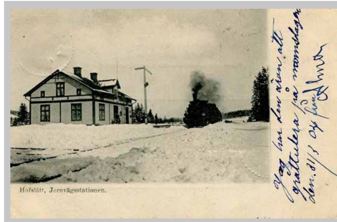
Hovslätt. Jernvägsstationen. Stämplat Hovslätt 29/3 1904. Stationen byggdes 1894, och var en förenad järnvägs- och poststation 12/11 1894–14/12 1950. De flesta stationshus utmed Vaggerydsbanan byggdes efter samma ritning och det är en förklaring till att de såg likadana ut. Från stationen i Hovslätt utgick mycket gods som industrierna sände ut i Sverige. 1966 stängde man helt. Stationen drogs in eftersom antalet resenärer hade minskat och godshanteringen var borta. Huset finns dock kvar än i dag.
