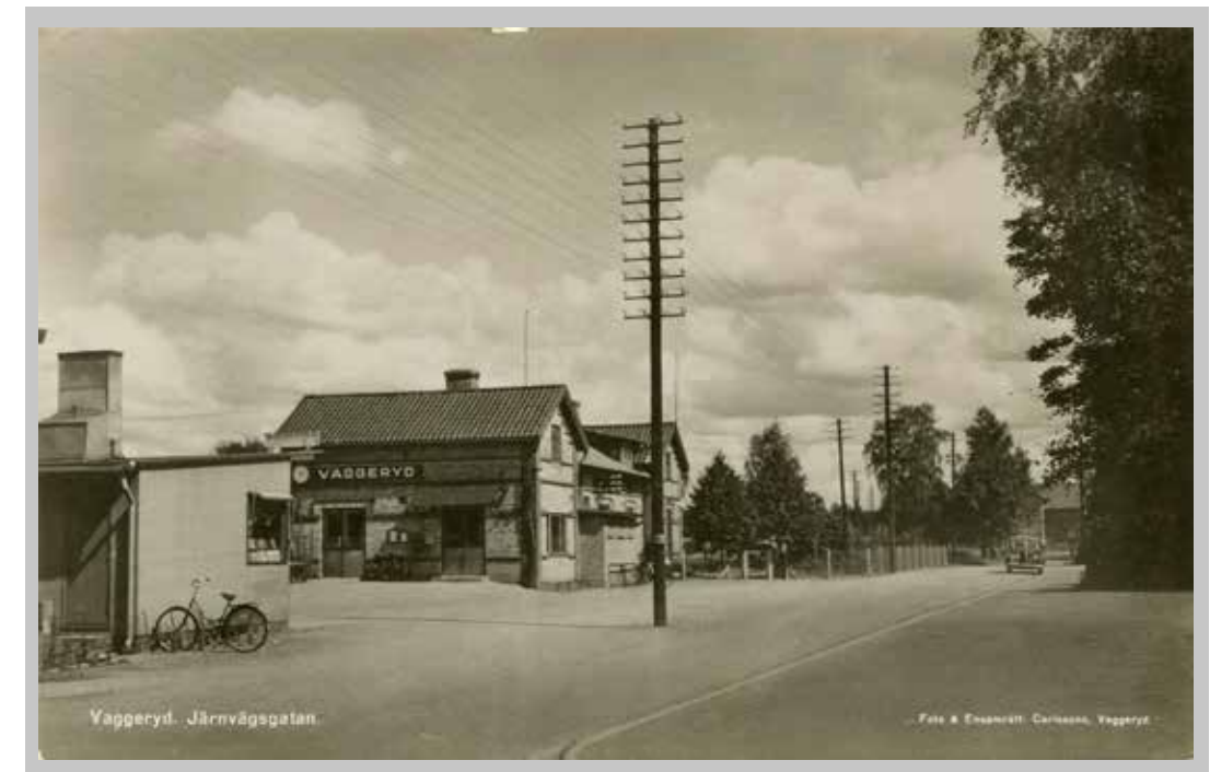
Vaggeryd. Järnvägsgatan. Foto & Ensamrätt: Carlssons, Foto, Pappers- och Musikaffär, Waggeryd. Stämplat 24/6 1949. Till vänster den klassiska kiosken – Pressbyrån. Pressbyrån i Waggeryd lades ned 1968 och lokalerna flyttades på hösten samma år till Aneby. Därmed var en 36-årig epok för Pressbyrån i Waggeryd över.
