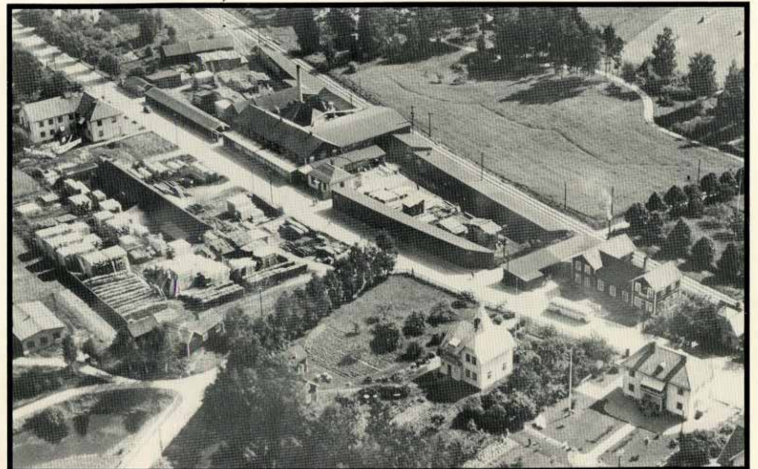
Flygbild över centrala Hovslätt 1946 Hovslätts Mekaniska Snickerifabrik med såg och brädgård. Till höger Hovslätts Möbelfabrik och Lindeborgs affär.
