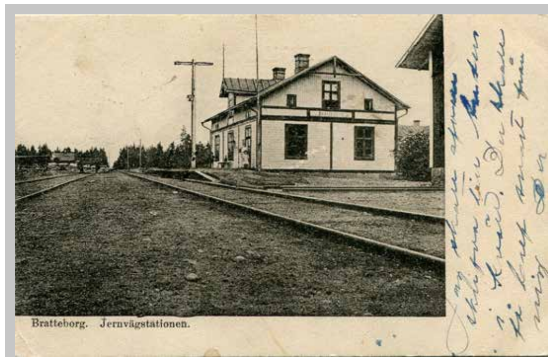
Bratteborg. Jernvägstationen. Stämplat Bratteborg 29/8 1906. Tryck 1905 eller 1906 (kortet har delad baksida som infördes 1905). Jernvägsstationen togs i bruk i november 1984 och 90 år senare revs den.
